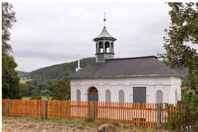
Pohled na opravenou kapličku od jihu.
