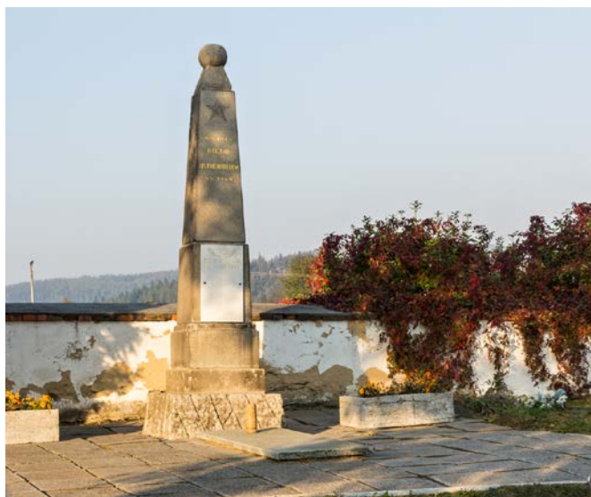
Pomník padlým na hřbitově - čištění, včetně dočištění sloupu a mramorových desek, čištění obrubníků, čištění květináčů, čištění dlažby, aplikace bioxidů, závěrečná povrchová úprava, hydrofobizace
